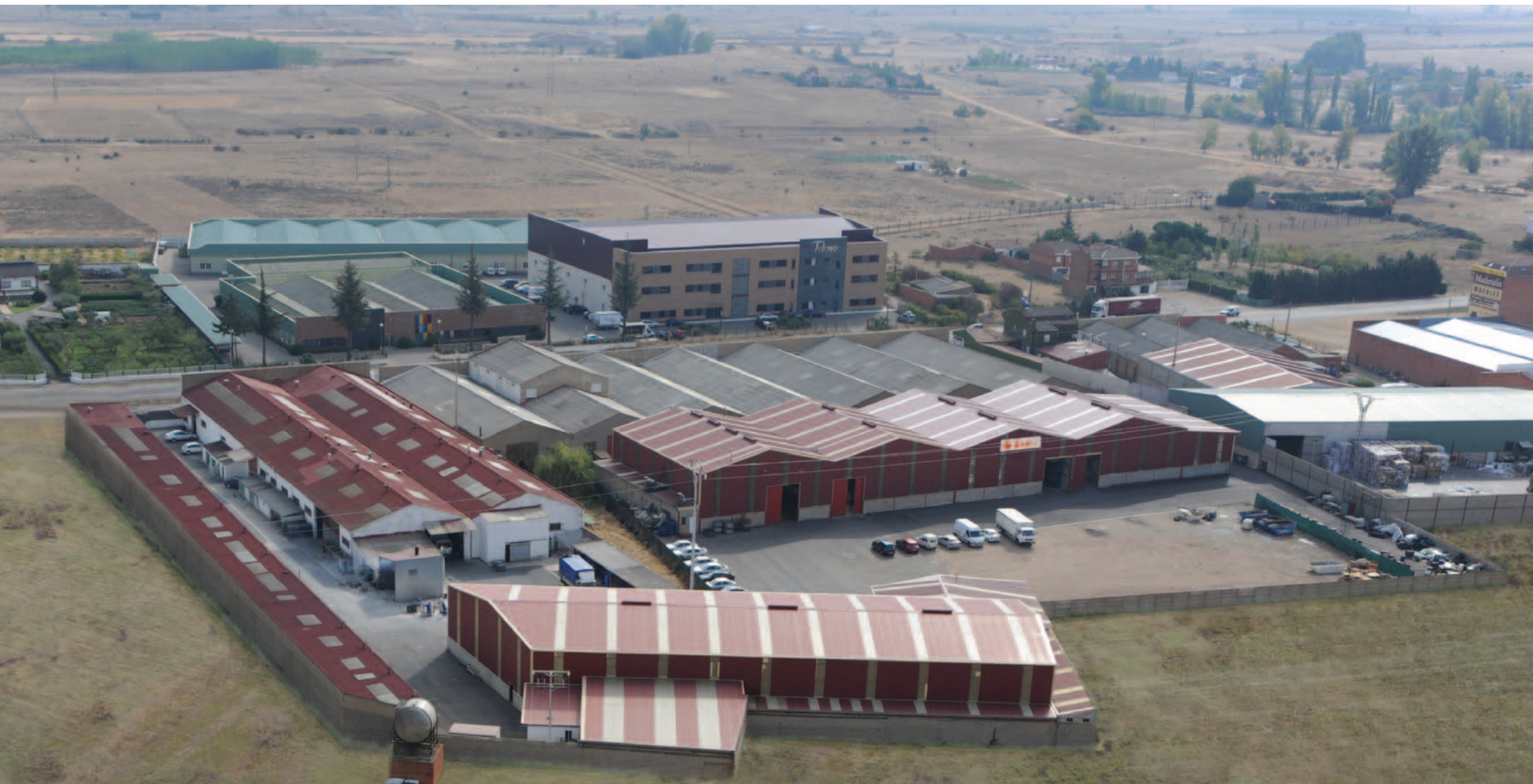
INSTALACIONES DE LA EMPRESA TOVIC, S.L. LEÓN - ESPAÑA FACTORY - TOVIC, S.L. LEÓN - SPAIN USINE DE TOVIC, S.L. À LEÓN - ESPAGNE
